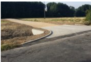
Zjazd i droga wewnętrzna - Reptowska Ptakowice
