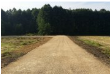
Zjazd i droga wewnętrzna - Reptowska Ptakowice
