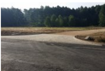
Zjazd i droga wewnętrzna - Reptowska Ptakowice
