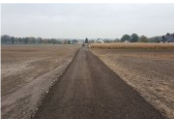
Wodociąg w ciągu ulicy Wąskiej w Wilkowicach
