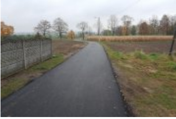
Wodociąg w ciągu ulicy Wąskiej w Wilkowicach
