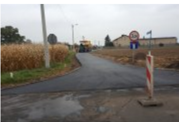
Wodociąg w ciągu ulicy Wąskiej w Wilkowicach
