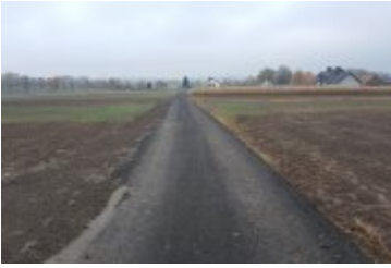
Wodociąg w ciągu ulicy Wąskiej w Wilkowicach
