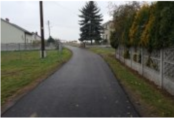
Wodociąg w ciągu ulicy Wąskiej w Wilkowicach
