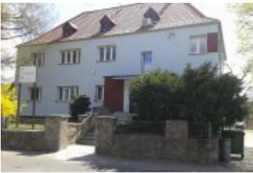
▶ Kompleksowa termomodernizacja budynków użyteczności publicznej mieszczących się na terenie Gminy Zbrostawice
