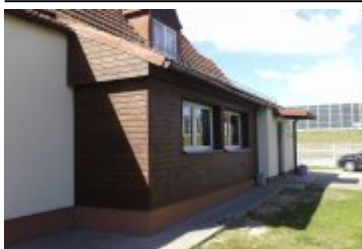
Kompleksowa termomodernizacja budynków użyteczności publicznej mieszczących się na terenie Gminy Zbrostawice
