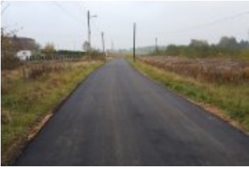
Ulica Piaskowa w Zbrostawicach
