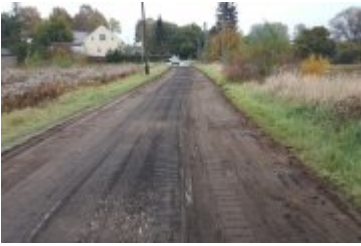
Ulica Piaskowa w Zbrostawicach
