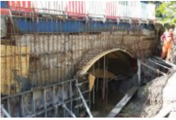
Remont mostu w Jaśkowicach
