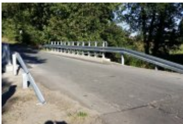
Remont mostu drogowego w Jaśkowicach
