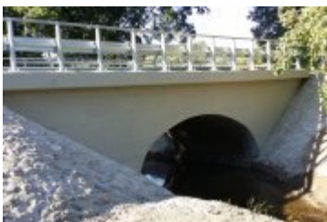
Remont mostu drogowego w Jaśkowicach
