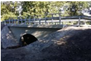
Remont mostu drogowego w Jaśkowicach
