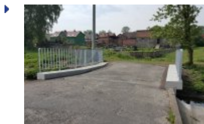
Remont przepustu w ciągu ulicy Dolnej w Świętoszowicach
