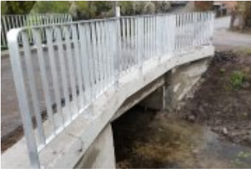
▶ Remont przepustu w ciągu ulicy Dolnej w Świętoszowicach
