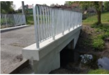
▶ Remont przepustu w ciągu ulicy Dolnej w Świętoszowicach
