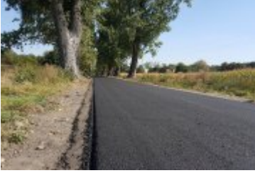
Droga boczna Łubie
