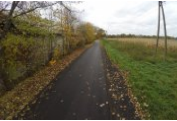
Przebudowa drogi bocznej od ulicy Pyskowskiej w Łubiu
