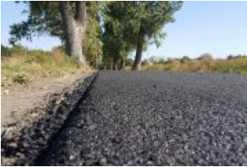
Droga boczna Łubie
