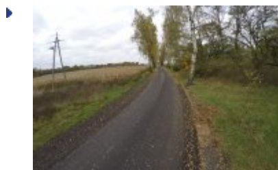
Przebudowa drogi bocznej od ulicy Pyskowickiej w Łubiu
