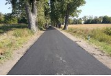
Droga boczna Łubie
