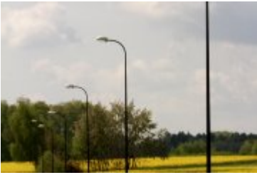
Budowa oświetlenia w Zbrostawicach
