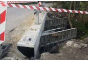
Remont mostu w ciągu ulicy Piaskowej w Zbrostawicach
