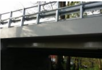
Remont mostu w ciągu ulicy Hutniczej w Zbrostawicach
