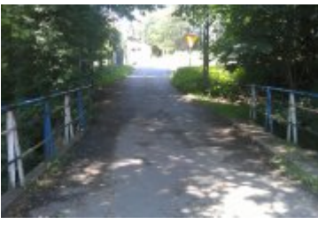
Remont mostu w ciągu ulicy Hutniczej w Zbrostawicach
