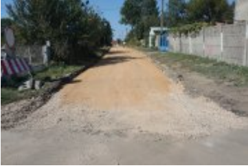
Remont ulicy Ogrodowej w Kopienicy
