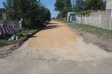
Remont ulicy Ogrodowej w Kopienicy
