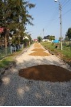
Remont ulicy Ogrodowej w Kopienicy
