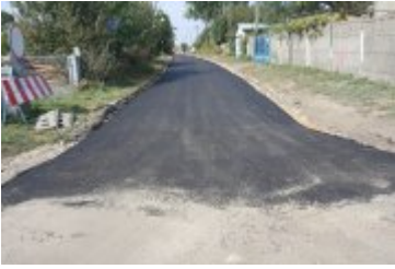
Remont ulicy Ogrodowej w Kopienicy
