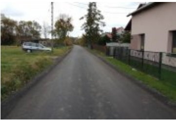
Remont ulicy Ogrodowej w Kopienicy
