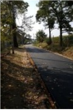
Remont ulicy Długiej w Jaśkowicach
