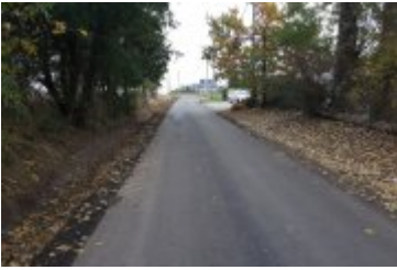
Remont ulicy Długiej w Jaśkowicach
